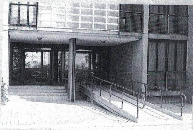
Fig. 13 Un esempio di rampa per l'accessibilità delle persone con disabilità motorie affiancata alle scale in un edificio di abitazione.
