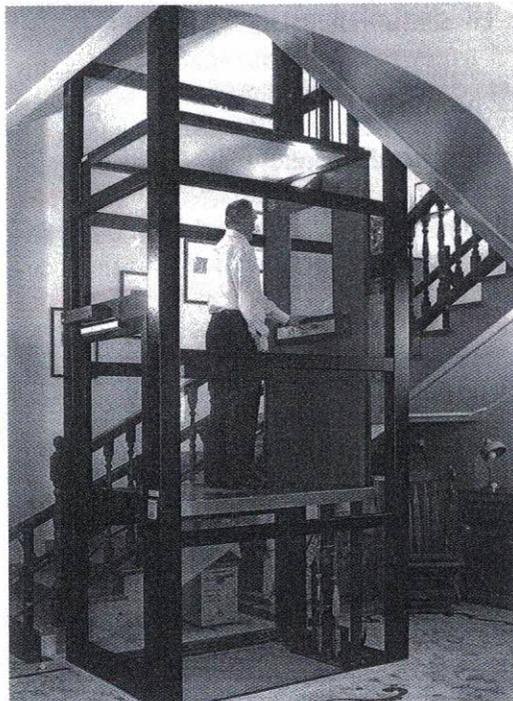
Fig. 9 Piattaforma elevatrice per disabili. Si noti il sistema di comando detto "a uomo presente" e il ridottissimo ribassamento rispetto al piano del pavimento (corrispondente al solo spessore della piattaforma). La piattaforma è sollevata da un dispositivo oleodinamico.
